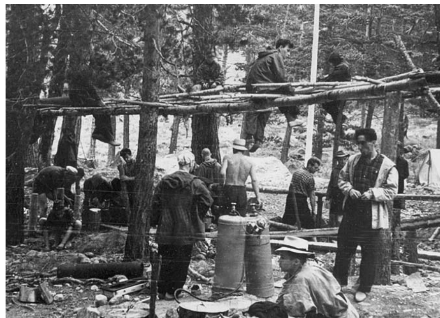
Строительство столовой в первой совместной альпиниаде МГУ - МВТУ 1956 г. Фото Малахова (1956)
