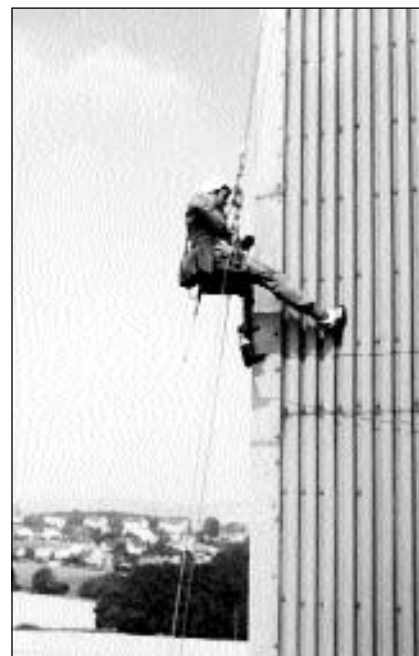
Спуск верхолаза по закрепленной веревке на «седушке»
