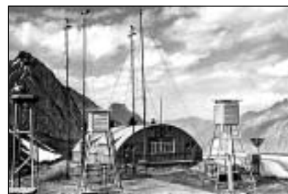
Здание станции им. Н.П.Горбунова
