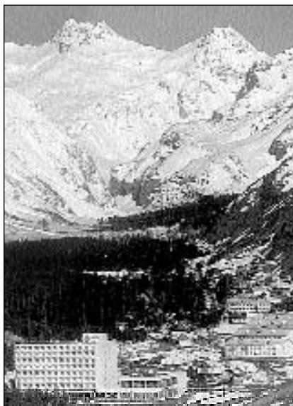
Здание военно-туристской гостиницы «Терскол». (На заднем плане участок ГКХ с вершинами р-на Азау, оборонявшихся советскими войсками во время ВОВ.)
